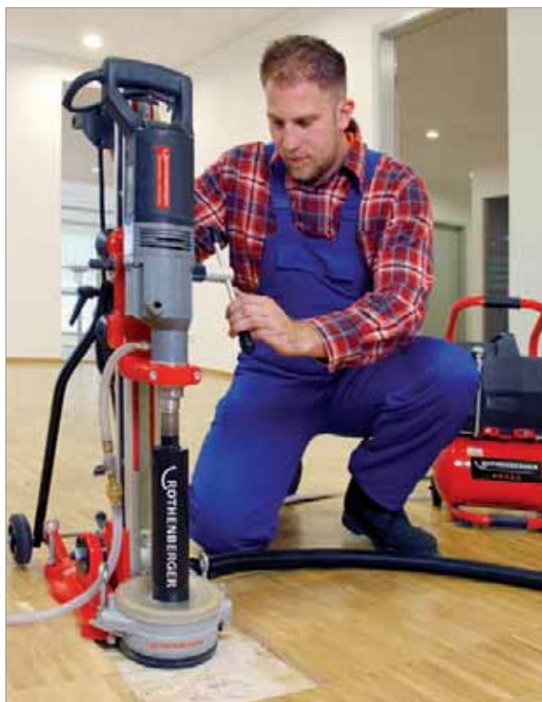
Чистая работа в закрытых помещениях с использованием водосборного кольца
